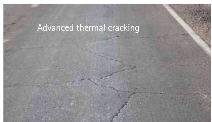
Bild 2: Ausmagerung durch gealtertes Bindemittel (links) und thermisch induzierte Rissbildung im fortgeschrittenen Stadium (rechts)
