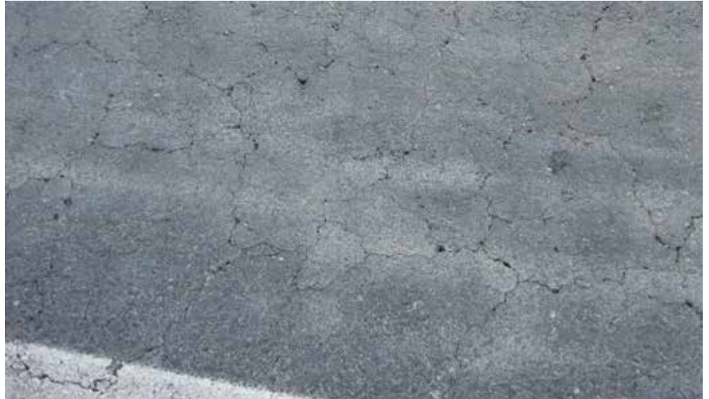
Bild 5: Durch die Risse werden feinere Partikel herausgeschleudert
