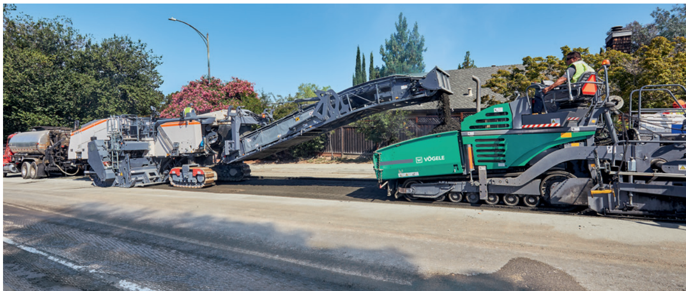
Abbildung 6: Herstellung von BSM mit W 380 CR(i) Kaltrecycler
