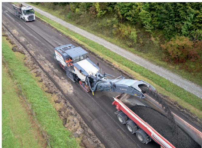
Abbildung 1: Ausbau der Asphalttschicht mit einer Kaltfräse
