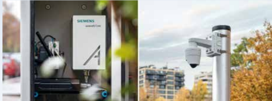
Bild 1: Die KI-Auswerteeinheit im Steuergerät (links) und Kamera am Mast
