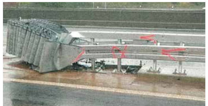
Mittels Anpralldämpfern wird die Aufprallenergie eines Fahrzeugs und somit das Verletzungsrisiko der Fahrzeuginsassen reduziert
