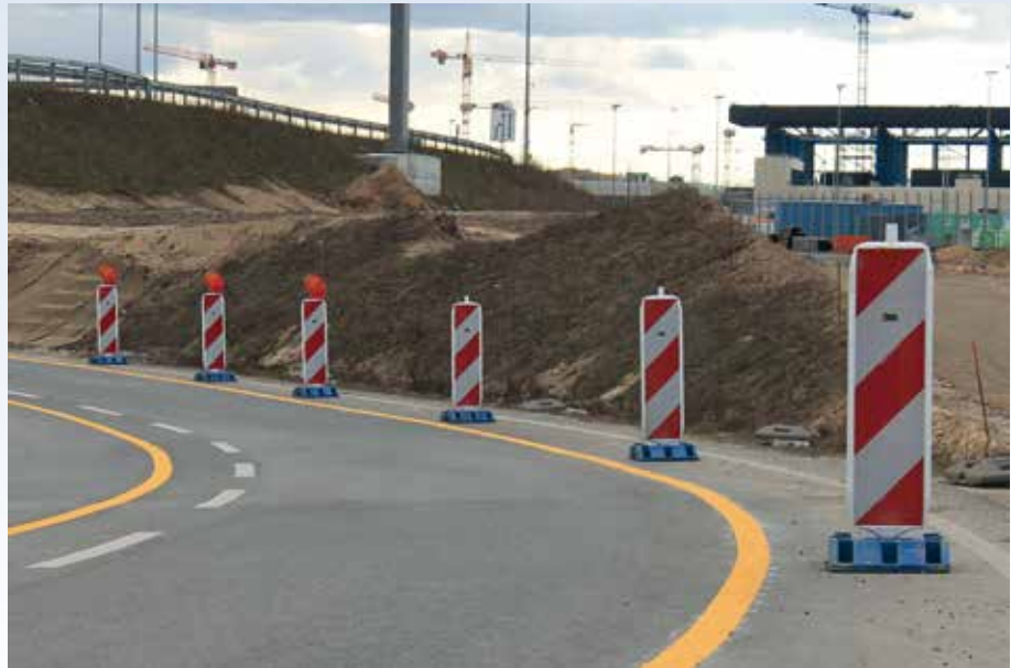
Bild 1: Neu bei WALLSTOP ist das Geschäftsfeld der Absicherung von Baustellen nach den gültigen Richtlinien der StVO, der RSA und den länderspezifischen Anforderungen (Quelle: WALLSTOP)
